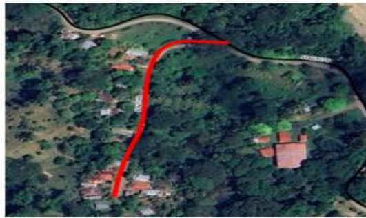
Figura N°1 Camino a intervenir se resalta con color rojo 2.3.2 Camino 6-06-106 (Ent.C.6060038) Asentamiento Sábalo, Sábalo a Fin de camino, Parcelas IDA:
