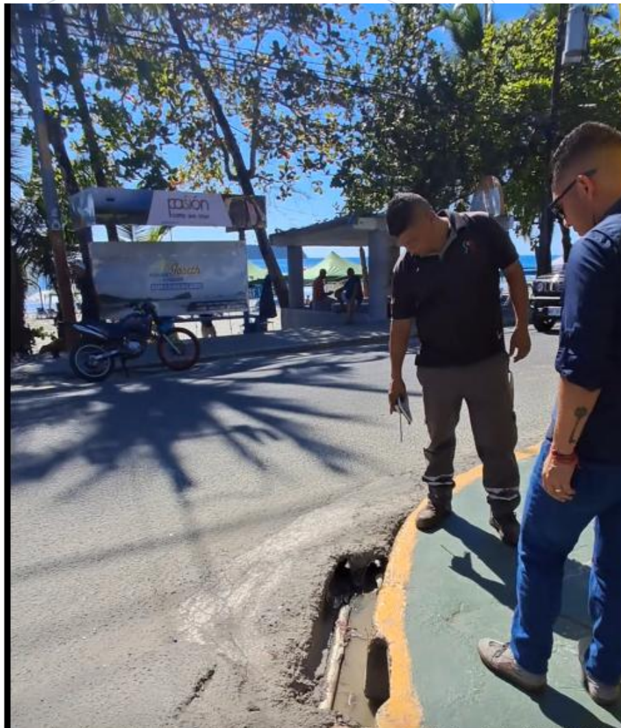
Imagen 3. Fotografía de inspección conjunta de diversas unidades y departamentos municipales realizada el día 14/01/2026 con el fin de valorar el aparente desfogue de aguas residuales en el sector de playa Espadilla Norte.
