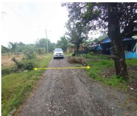
Imagen 5 y 6. Canal pluvial sobre propiedad privada sin la adecuada geometría, paso de alcantarilla no cuenta con la capacidad hidráulica.
