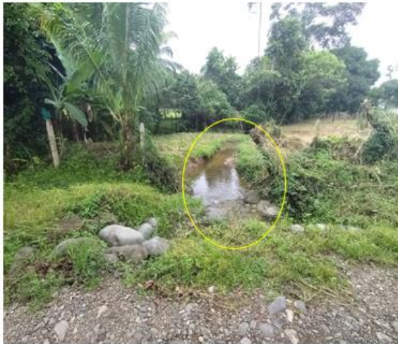
Imagen 5 y 6. Canal pluvial sobre propiedad privada sin la adecuada geometría, paso de alcantarilla no cuenta con la capacidad hidráulica.
