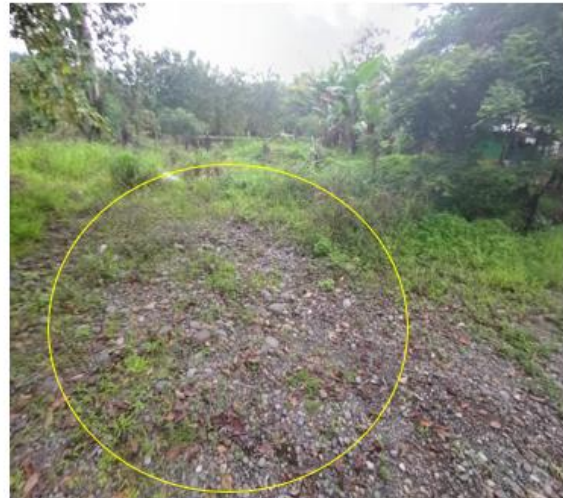
Imagen 3 y 4. Canal pluvial sobre propiedad privada fue clausurado por el dueño registral mediante una tapia perimetral y material granular generando que el agua circule sin rumbo hacia los puntos más bajos.
