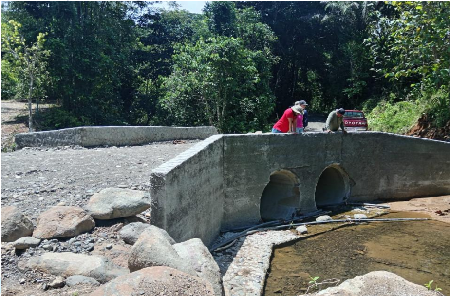
Imagen 1. Proyecto construcción paso de alcantarilla comunidad de San Cristóbal.
