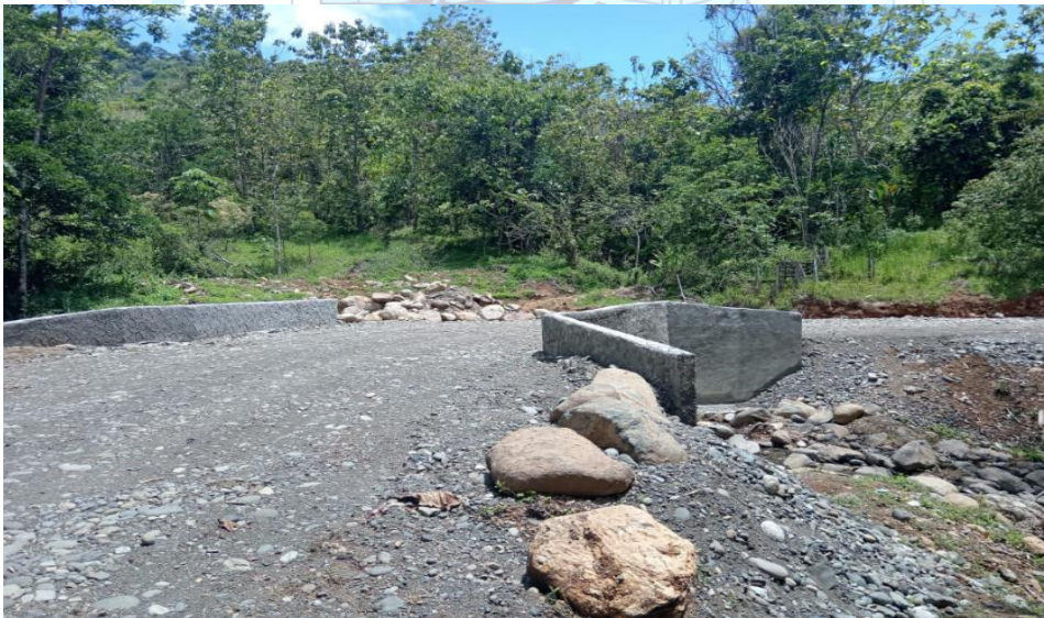
Imagen 2. Paso de alcantarillas con mano de obra del comité de caminos de San Cristóbal.-
