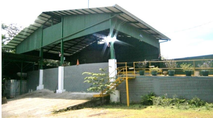
3 4 Fachada del Centro de recuperación y transferencia de residuos --- 5
