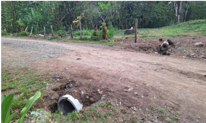
2 Imagen N#4 salida de desfogue existente.---
