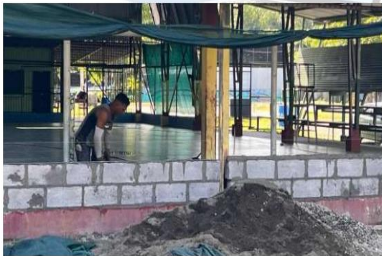
Imagen 7: Trabajos en muro y malla del sector trasero.
