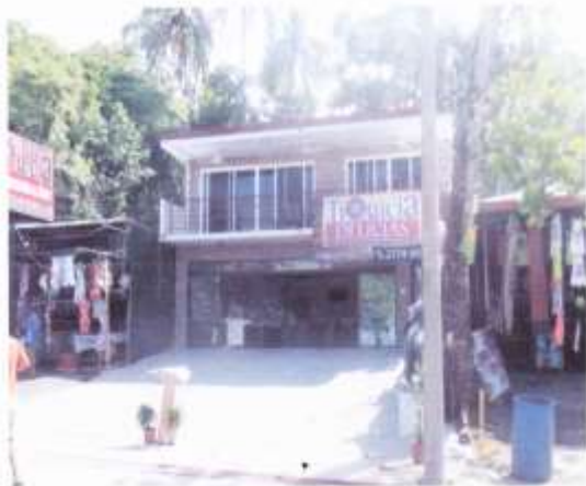
Vista frontal del proyecto, no guarda retiros laterales
